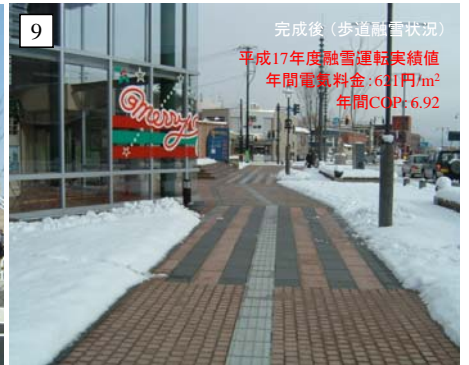
地中熱: 約5年分の運転実績値より。在来系: (融雪)電熱線方式 + (冷暖)空冷チラー + (暖房)灯油ボイラー
